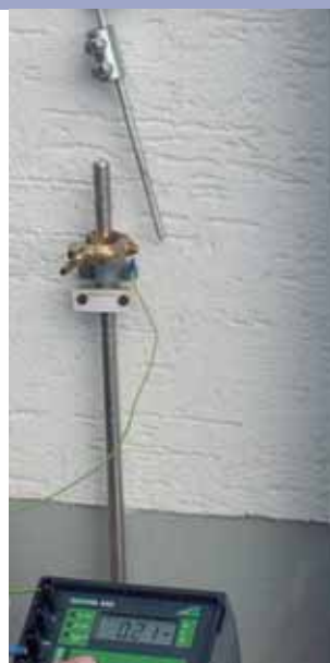
Вимір опору заземлення
