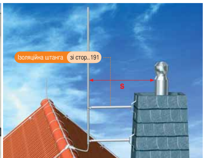
Правильно витримана відстань віддалення s між вловлюючим пристроєм та каманом із нержстали
